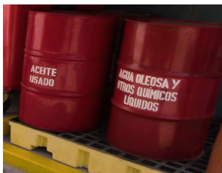
Punto de acopio de residuos peligrosos y no peligrosos - Sistema de contención
